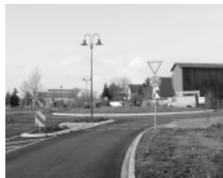
Der neue Verkehrskreisel in der Reilinger Straße.
